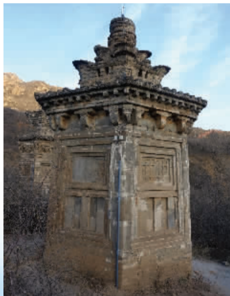
■万寿寺塔林之6号塔侧影。
