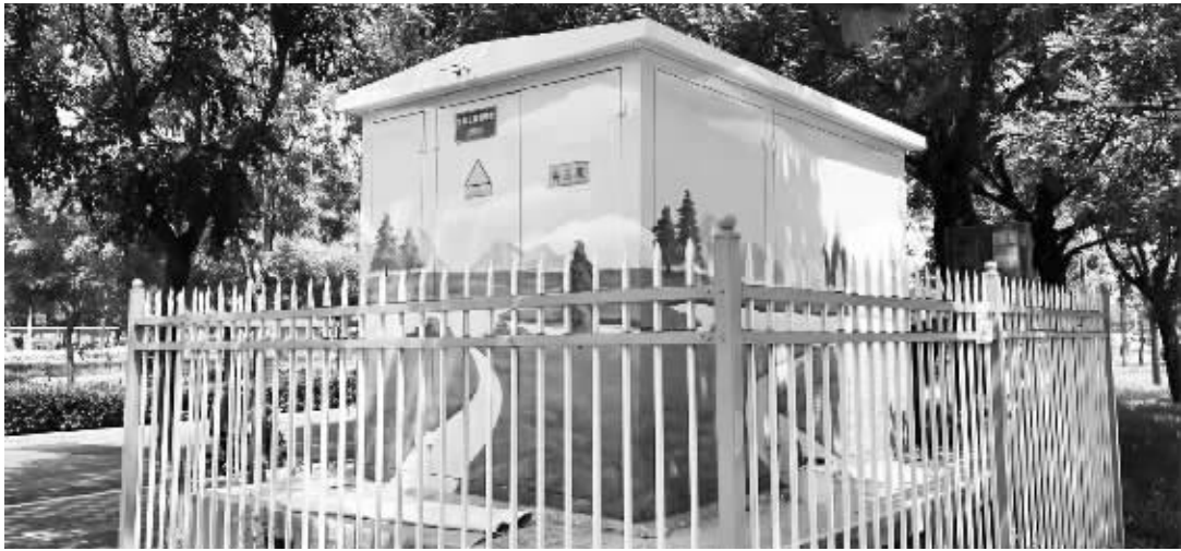
■变压器换装,扮靓城市。
