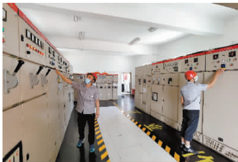
■工作人员正在检查雨水泵站的配电室。
