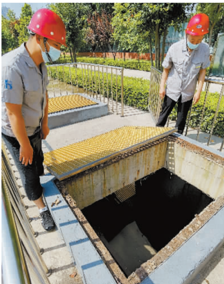
■工作人员正在检查雨水泵站。
