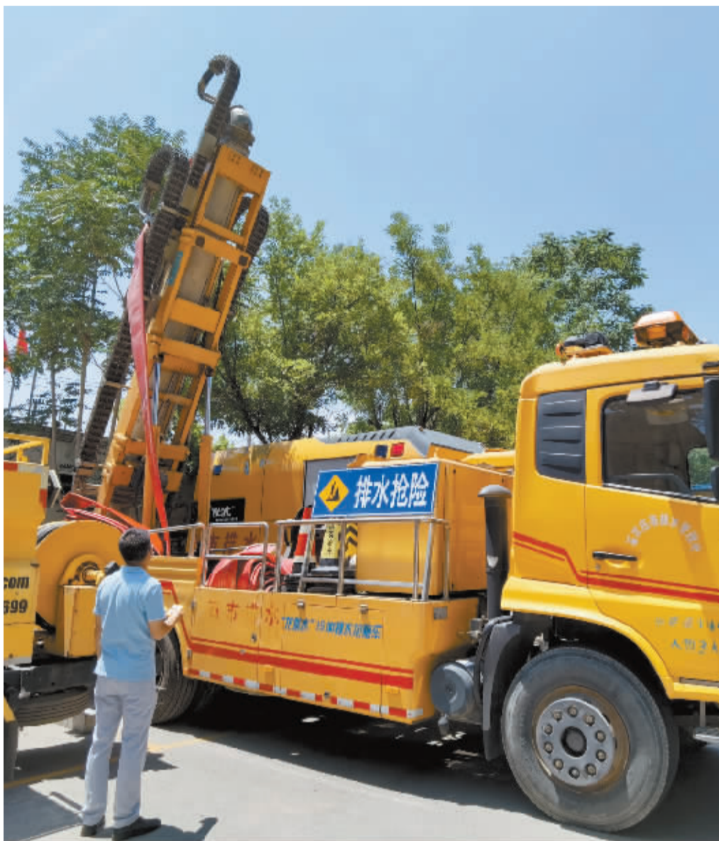
■市排水管护中心的工作人员正在检查维护排水设施。
