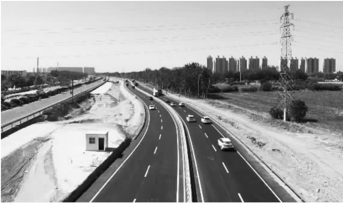
■6月1日凌晨,南二环东延线与复兴大街互通立交匝道及附属工程保通路开放通行。通讯员 邢宇森 摄
