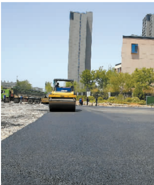
■施工人员进行道路收尾。
