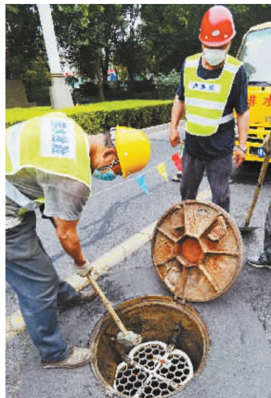
■工作人员正在安装防坠隔板。
