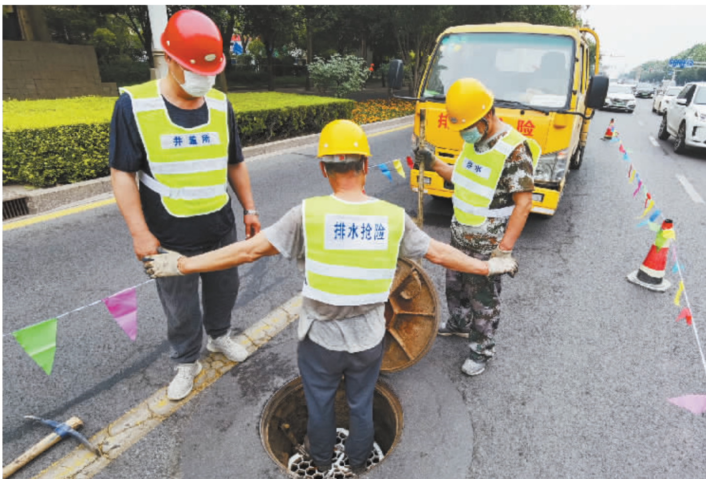
■现场验证防坠隔板的承重。
