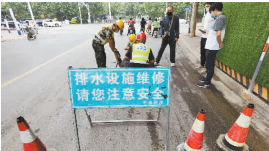
■排查安装施工现场。
