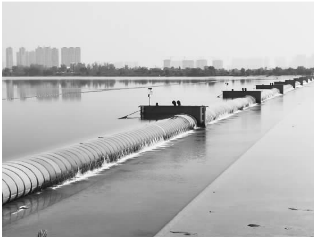
■滹沱河 800 米长的橡胶坝调节补水。
