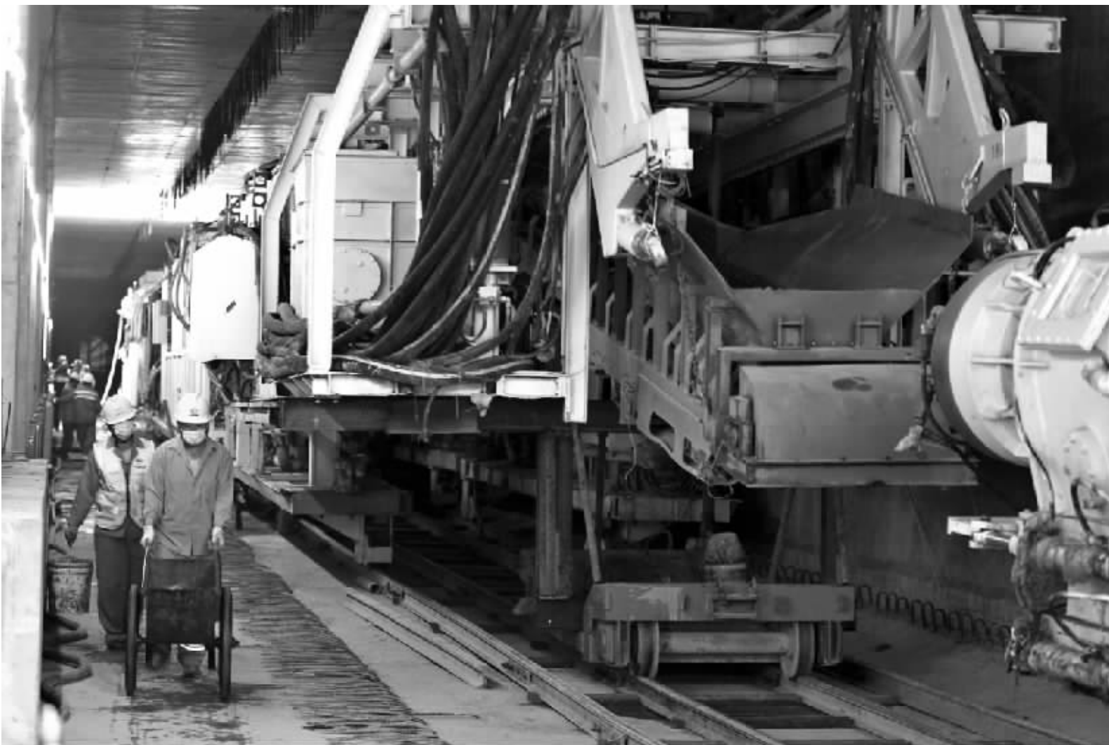
■在东上泽站,盾构台车已吊装下井。
