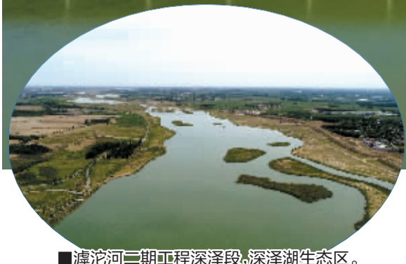
■滹沱河二期工程深泽段,深泽湖生态区。
