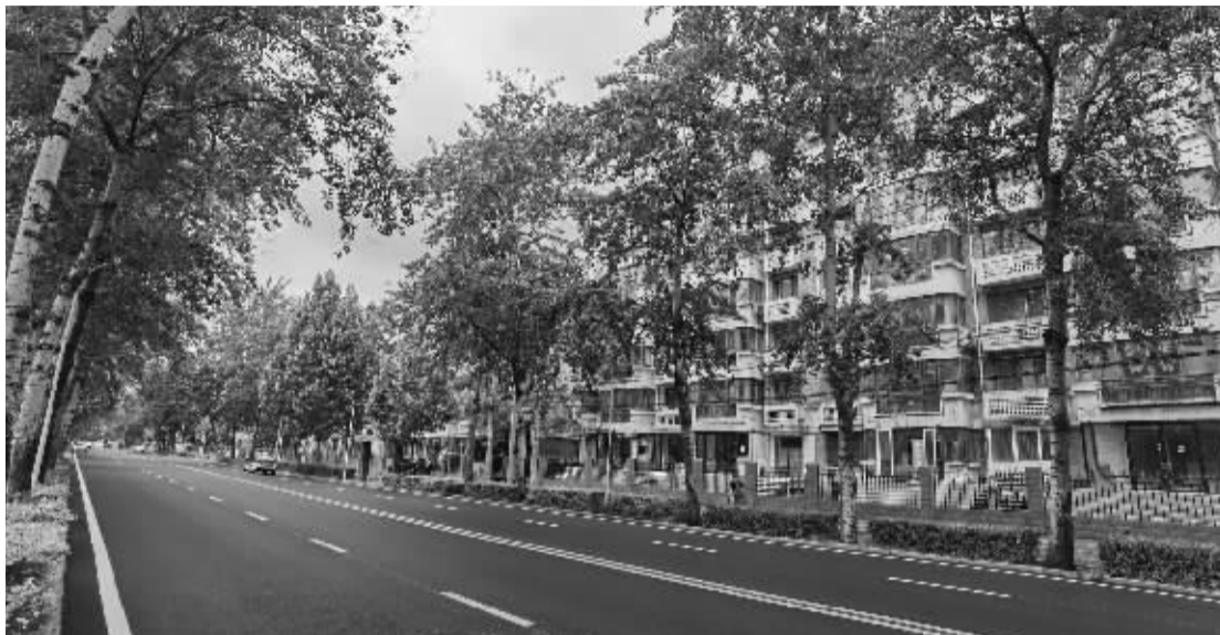
■升级改造后的马路宽敞平坦。 本报记者 李青 摄
