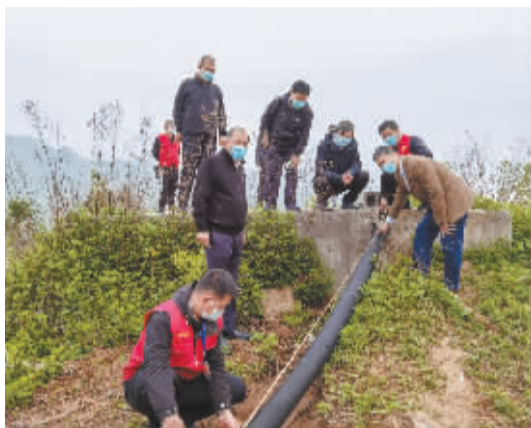
■湾子村饮用水管道提升改造紧张施工。
