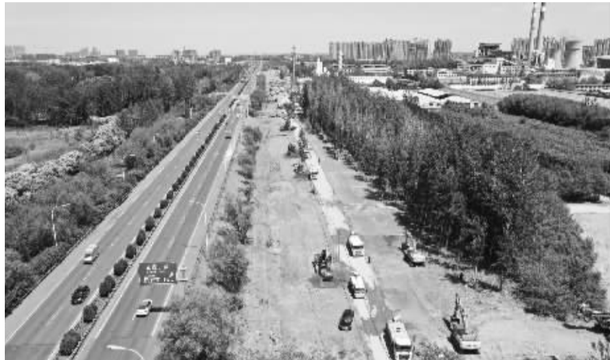
■正定隧道施工现场。本报记者 冯月静 通讯员 张雅文 摄
