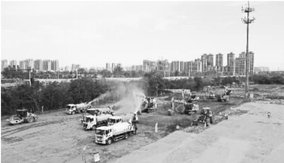
■白佛隧道施工现场。
