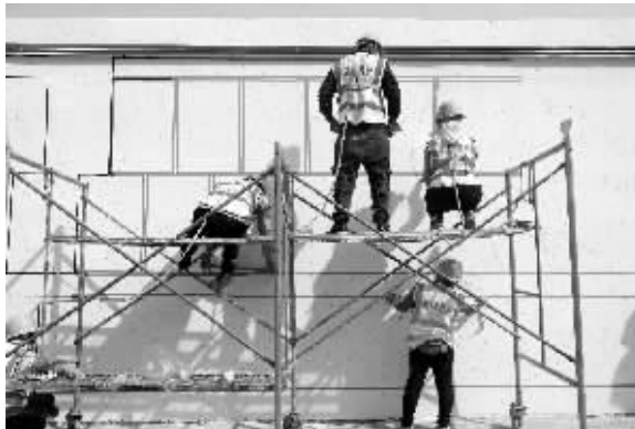
■施工人员正在对墙体进行粉刷美化。本报记者 赵晓华 摄
