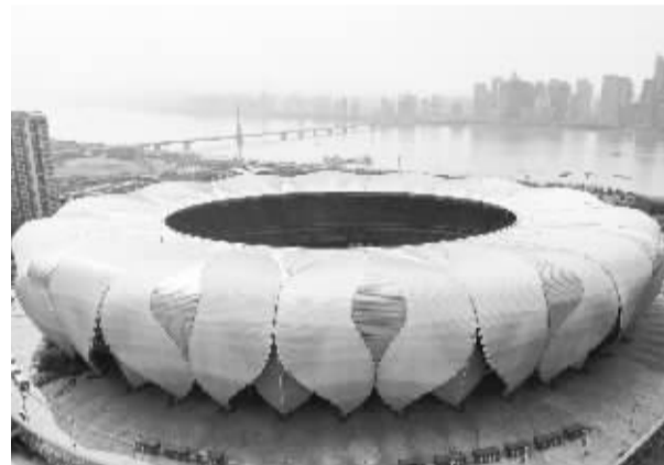
■历时近 5 年建设后,杭州 2022 年亚运会、亚残运会 56 个竞赛场馆全面竣工并通过赛事功能综合验收。图为杭州奥体中心体育场。 新华社发
