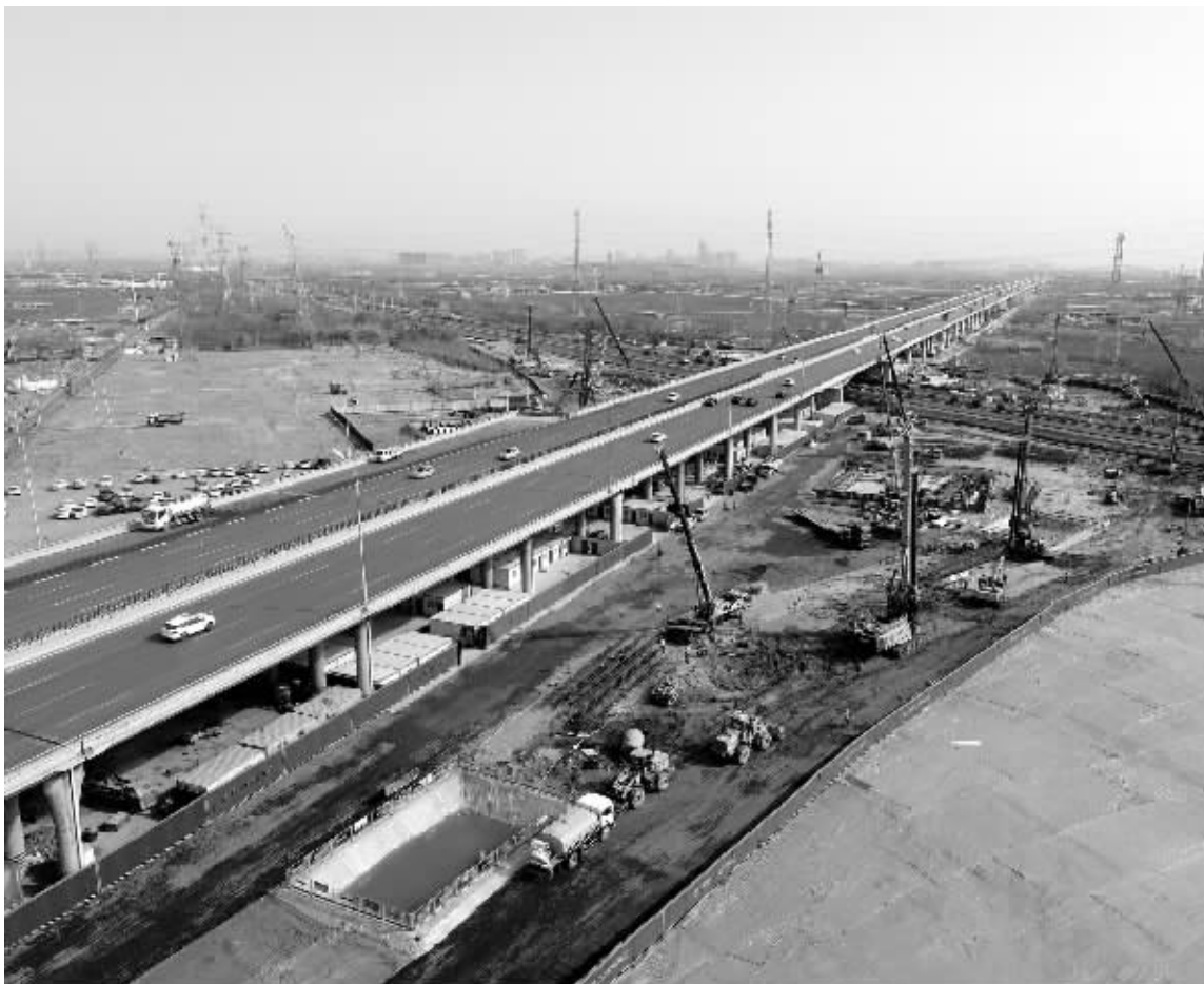
■复兴大街连接新城大道互通立交施工现场。本报记者 张海强 摄
