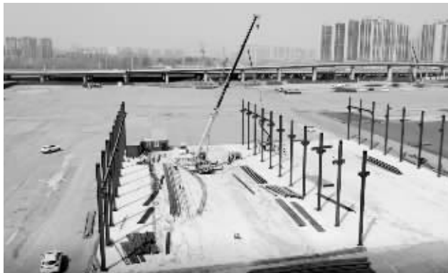
■南二环东延线与复兴大街互通立交工程现场。通讯员 张雅文 摄
