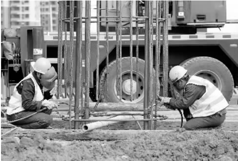
■复兴大街市政化改造工程现场,建设者在忙着捆扎钢筋笼。
