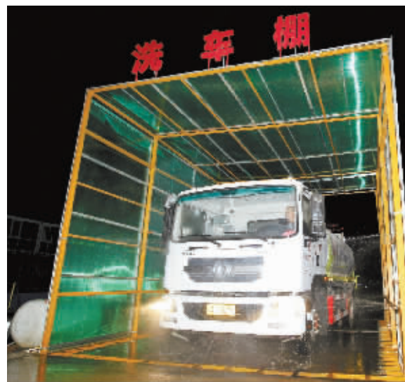
■工地洗车棚对进出车辆进行冲洗。
