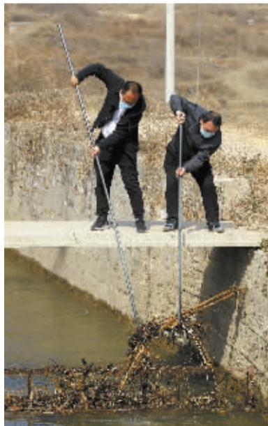
■工作人员打捞水渠内的漂浮物。
