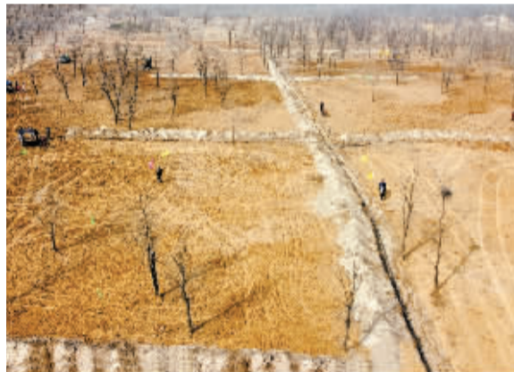
■管道铺设现场。
