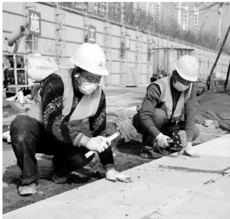
■施工人员正在加紧施工。
