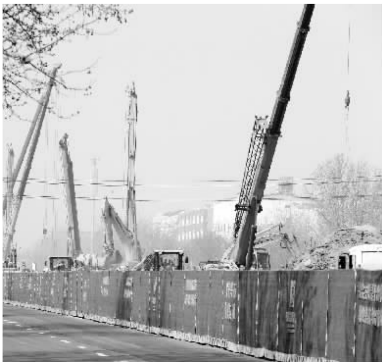
■众多设备正在紧张施工。
