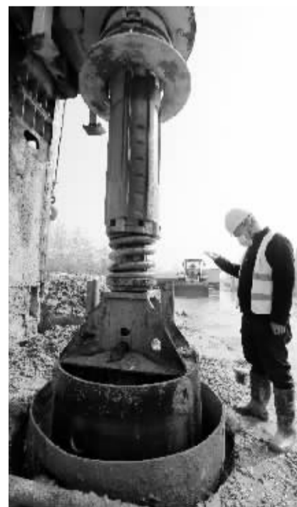
■施工人员指挥旋挖钻机进行作业。
