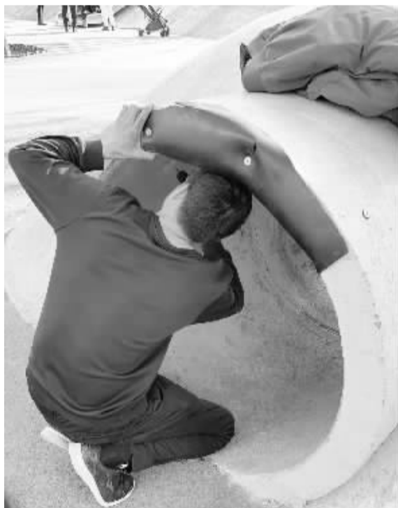
■体育公园为儿童游乐设施加装了橡胶垫做防护。(公园供图)
