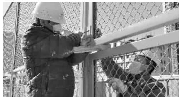
■工人在紧张施工。
