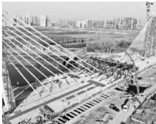
■大桥成功实现合龙。
