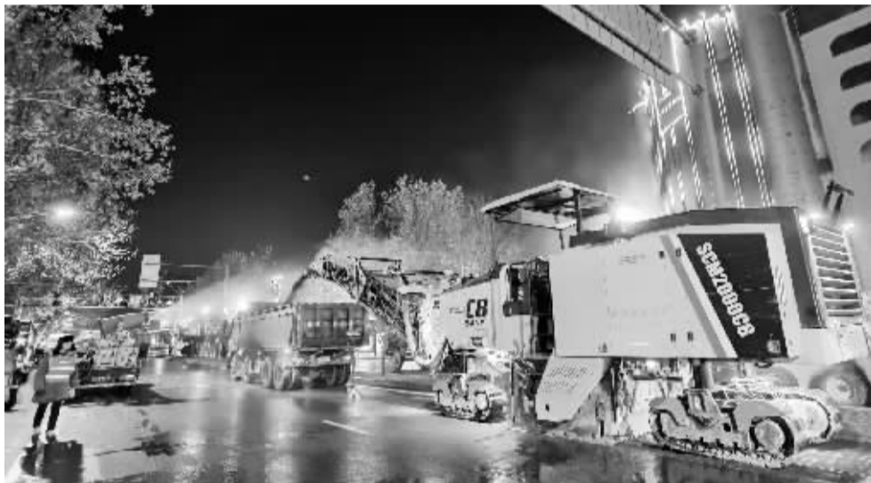
■胜利北大街运河桥至古城东路段昨夜已开始施工。本报记者李青摄
