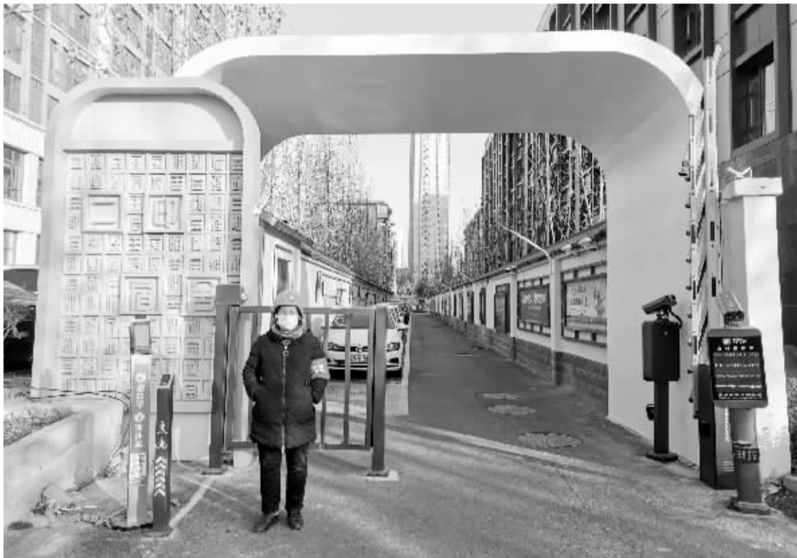
■ 裕华区二印宿舍改造后,居民感觉更宜居更美好。
