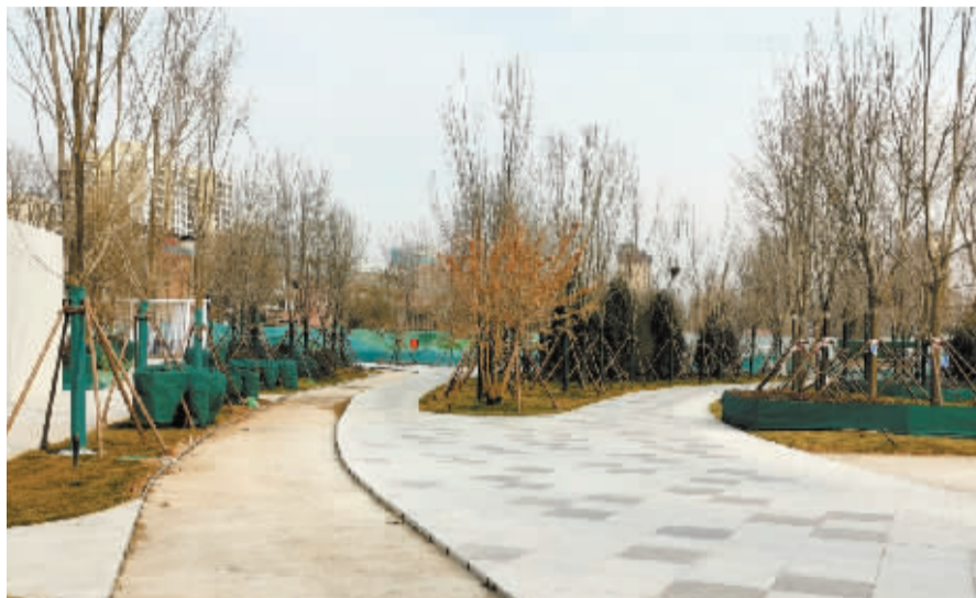
■占地 64 亩的智慧体育公园基础设施建设正在完善。
