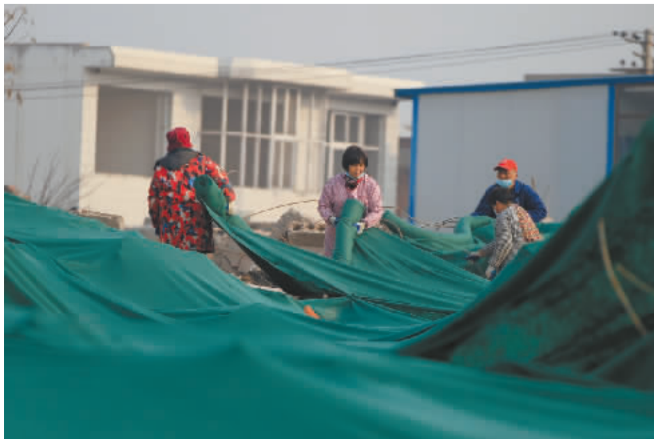
■为了防止扬尘,将无纺布盖在建筑垃圾上。
