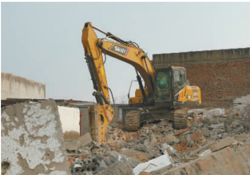
■使用大型机械进行拆除。
