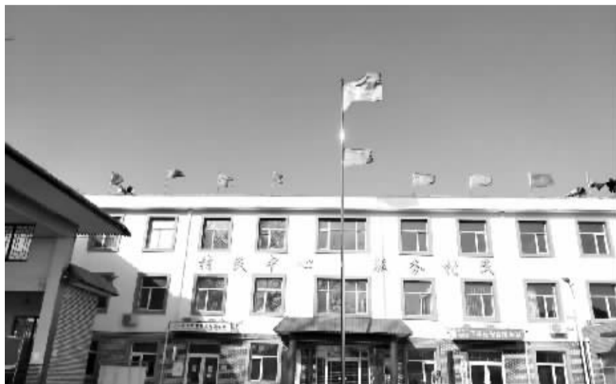
■下聂庄村综合服务站。
