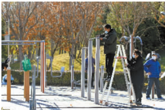
■检修加固健身器材。
