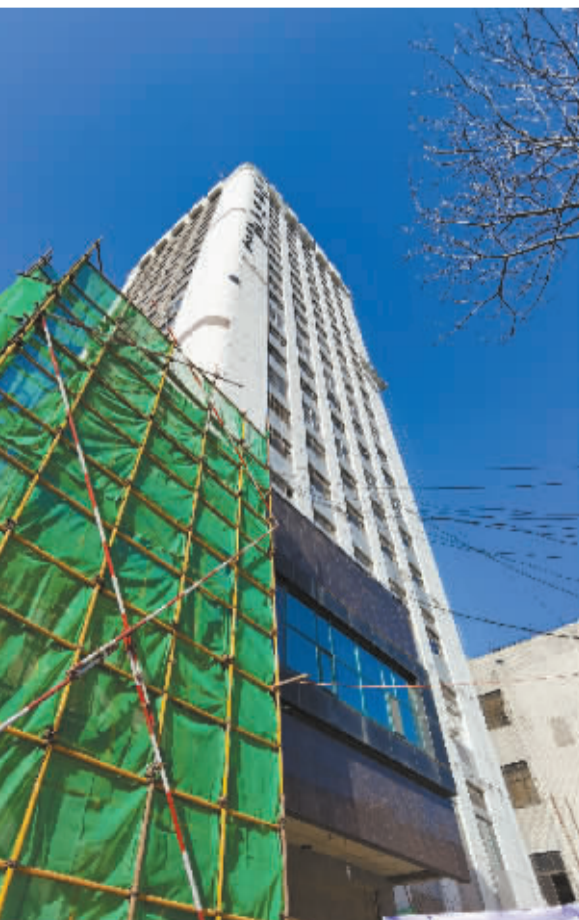
■华都大厦的楼体立面正在进行整治提升。
