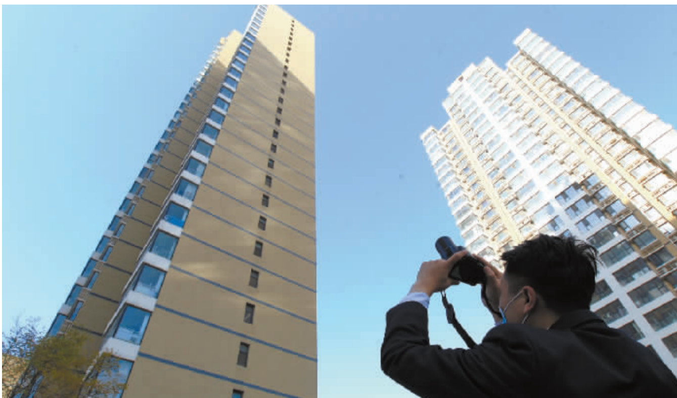
■小区物业人员正在用高倍相机查看大楼外墙情况。
