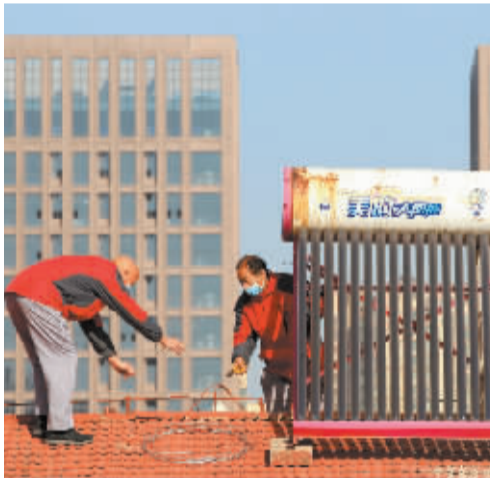
■对年久失修的太阳能热水器进行拆除或加固。
