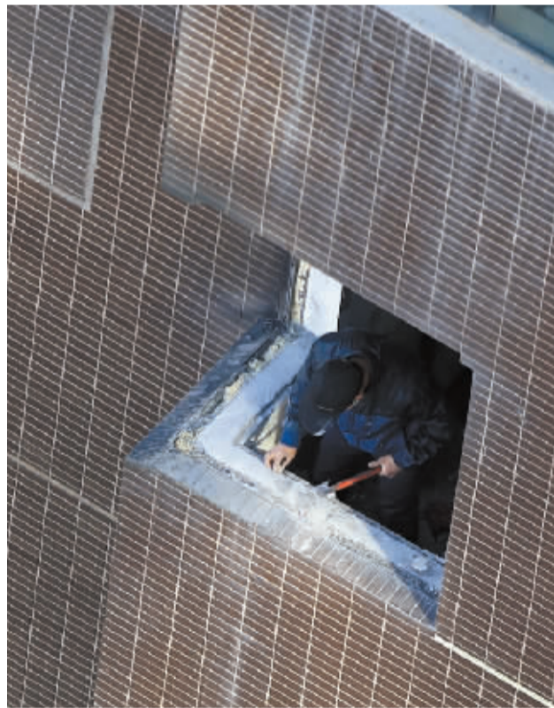
■某高层住户正在装修。
