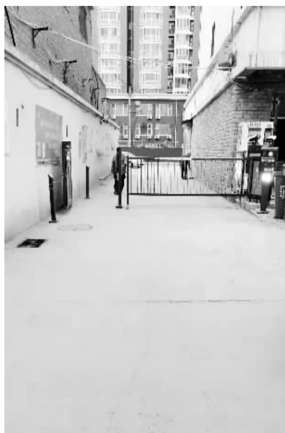
■排污管道更换施工结束,小区道路恢复畅通。
