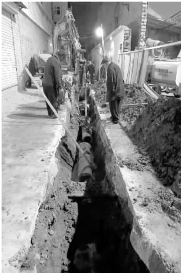
■施工方加班加点施工。
