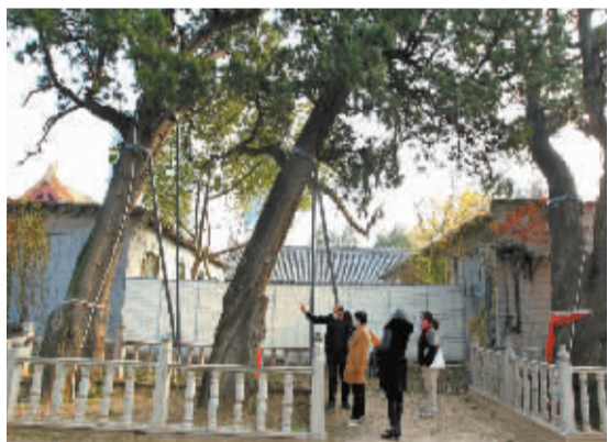
■经过重新进行支撑和加固的古柏。
