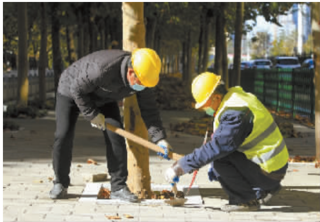
■施工人员正在做最后的收尾工作。
