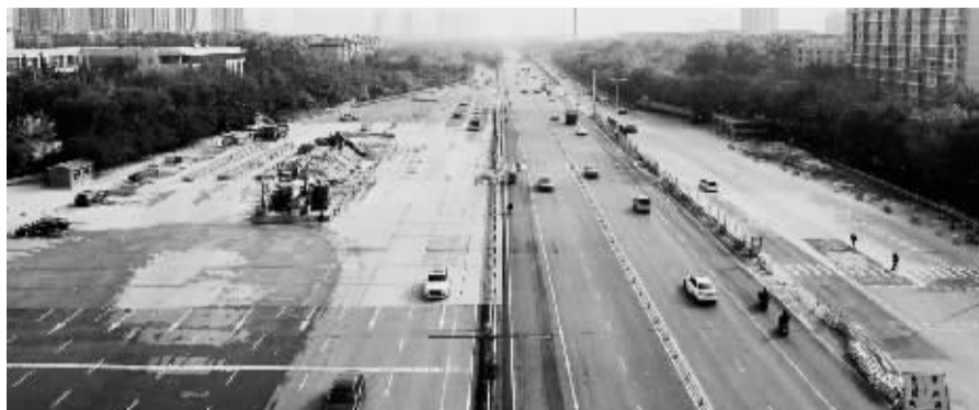
■裕华路高速口收费站拆除完毕。本报记者 张海强 摄
