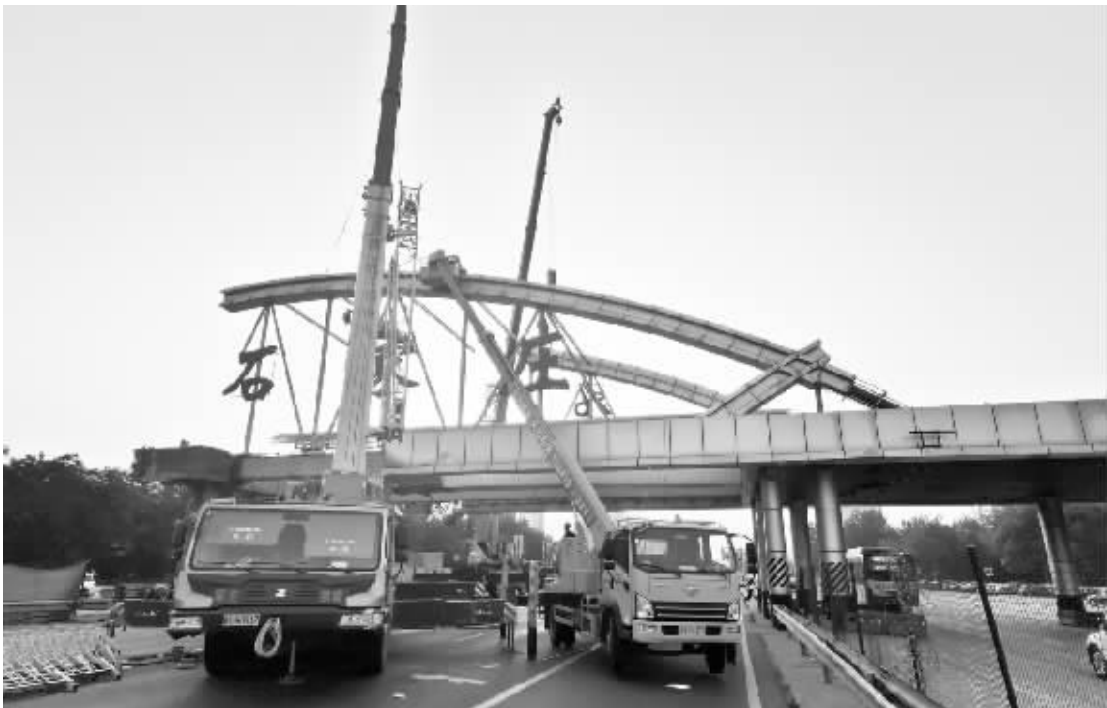
■裕华高速口的龙门架拆除现场。 本报记者 张海强 摄
