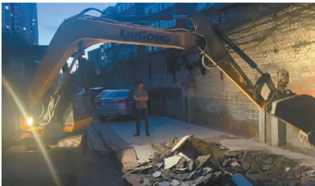
■沧州路提升改造刚施工时的状态。
