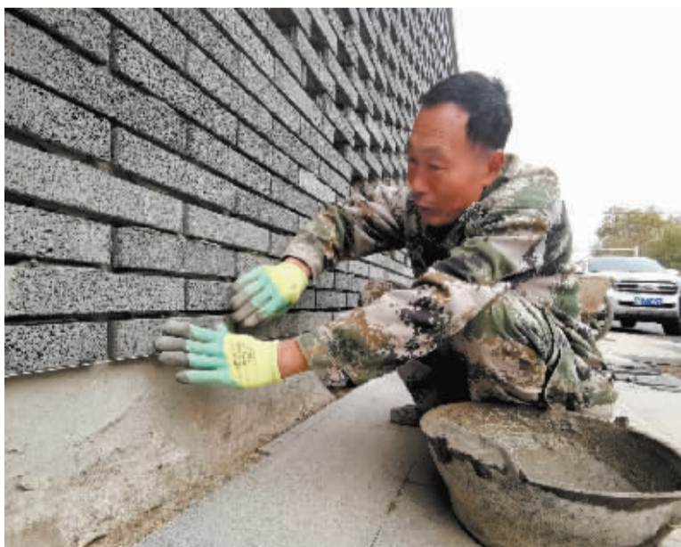
■施工人员在做收尾工作。
