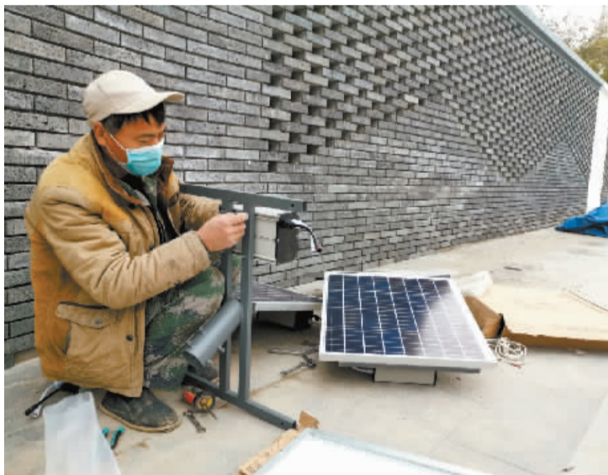
■施工人员正在安装太阳能路灯。
