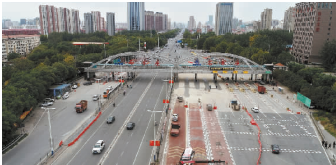
■裕华路高速口开发区方向收费站正在拆除。本报记者 张海强 摄
