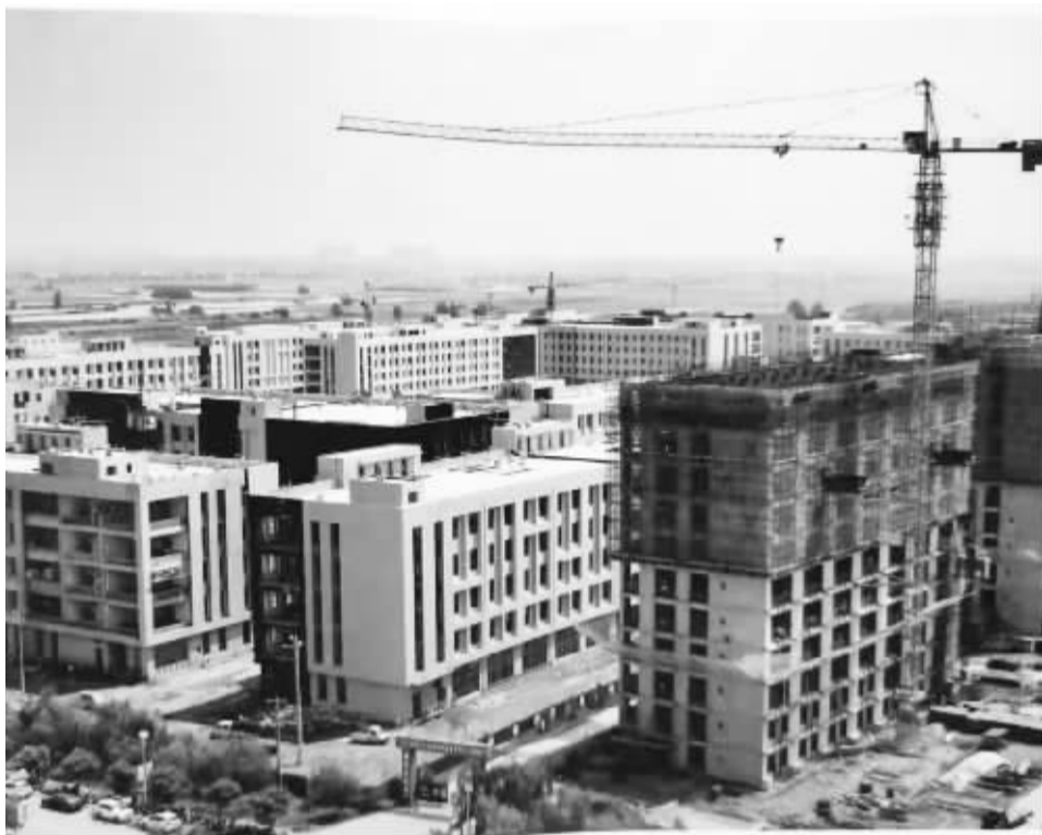
■建设中的中国北方鞋都(高邑)特色小镇 PPP 项目。
