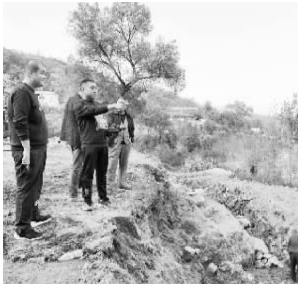
■查看加固村委会广场边护河堤施工进度。
