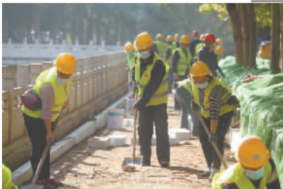
■改造施工热火朝天。
