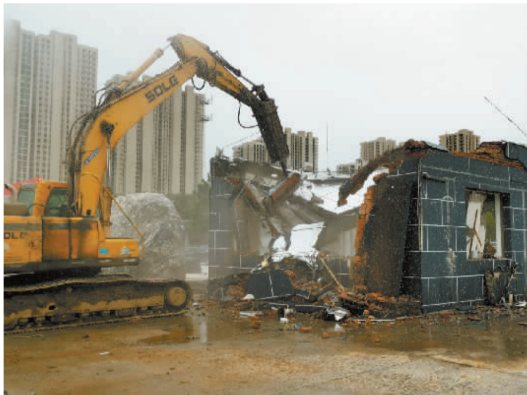
■昨天,位于省会东二环与北二环交会处的昌泰石化加油站完成拆除,腾出空间将用于建设北二环与307国道副线高架连接线以及城市绿化带,此举对缓解主城区及周边交通压力、拓展城市发展空间、助力省会高质量发展具有重要意义。 本报记者 张海强 摄
