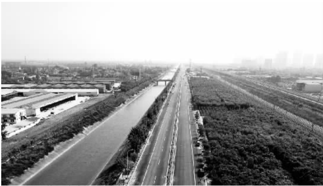
■307项目开放通行标志着102.3公里三环辅道全线贯通。
