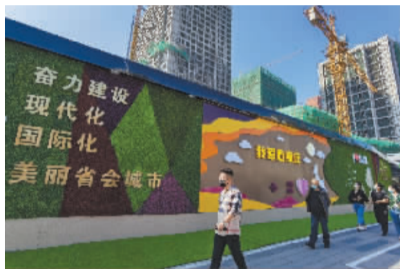
■工地围挡变身网红打卡地。
