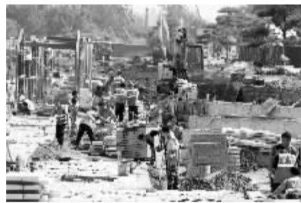
■太平河南岸绿道贯通工程正在紧张施工。
