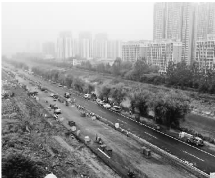
■307复线便道、画线施工正紧张进行。邢宇森 摄
