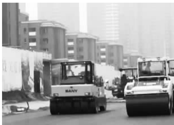
■现场正在铺油。 通讯员 邢宇森 摄
