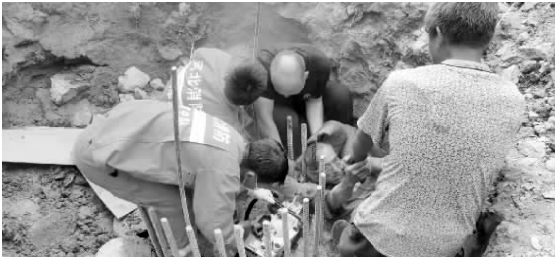
■消防救援现场。
